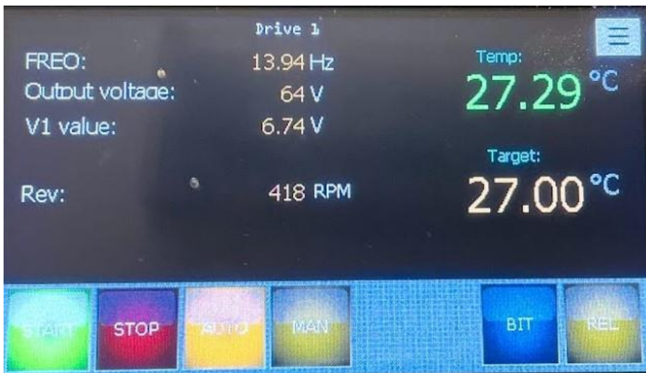
1Marha istálló vezérlés low-cost példa
